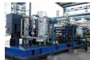
10万吨/年液态CO 2 工程项目 油田驱油项目
